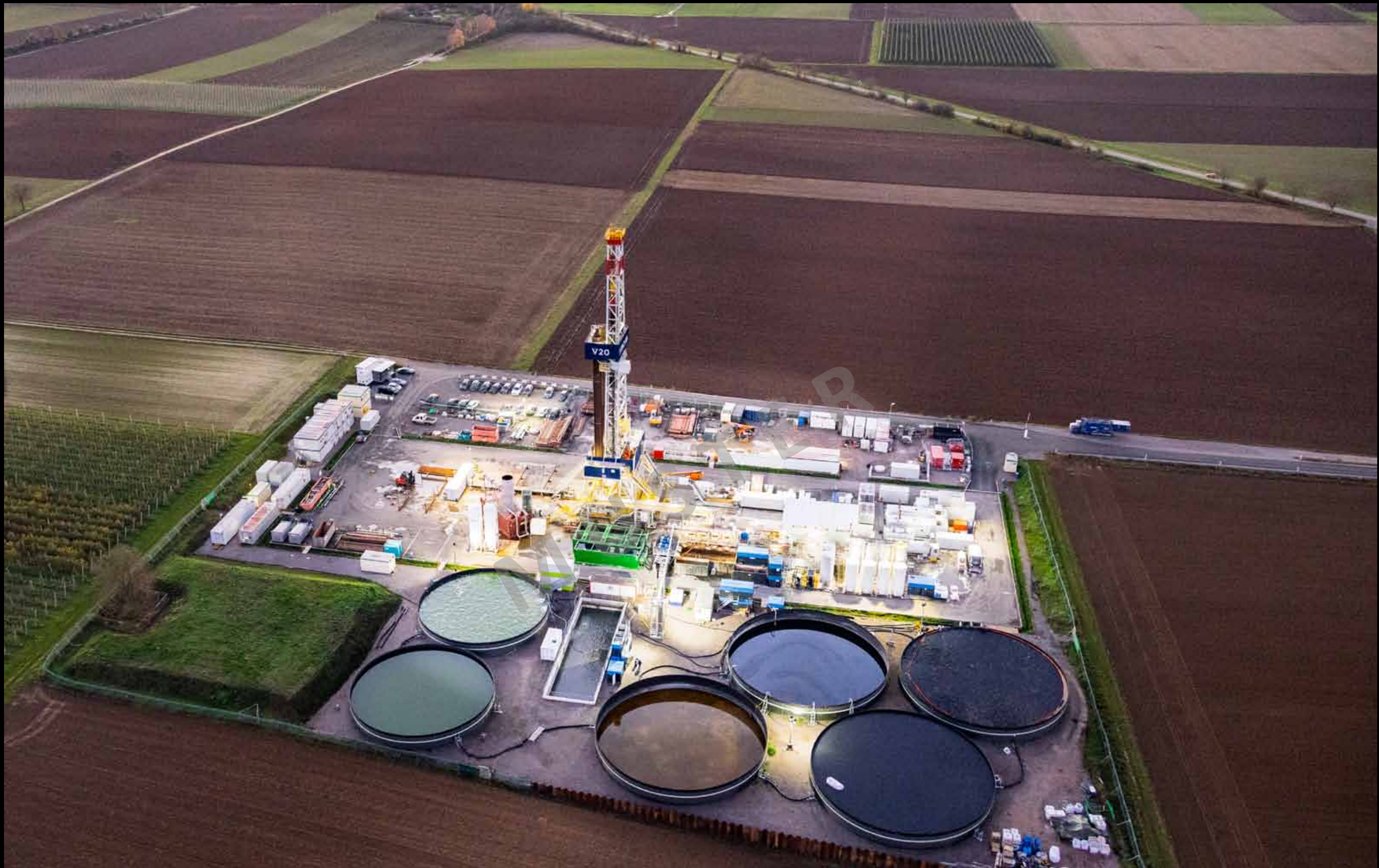
Tiefenbohrplatz von Vulcan Energy am Schleidberg zur Geothermieförderung und Lithiumgewinnung in Insheim 18.11.2025
