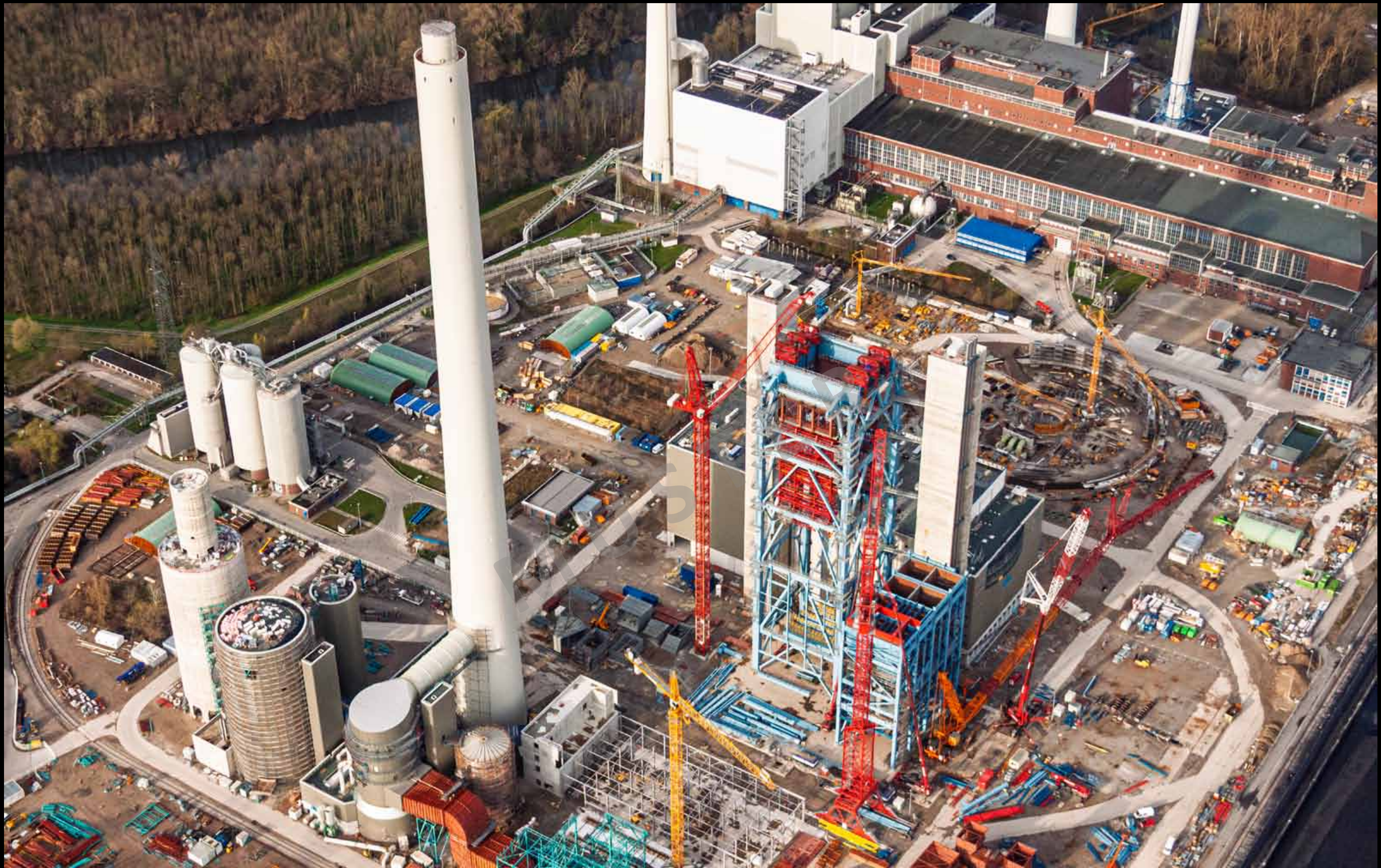
Neubaubastelle Steinkohlekraftwerk des Rheinhafen-Dampfkraftwerk Karlsruhe 02.04.2010
